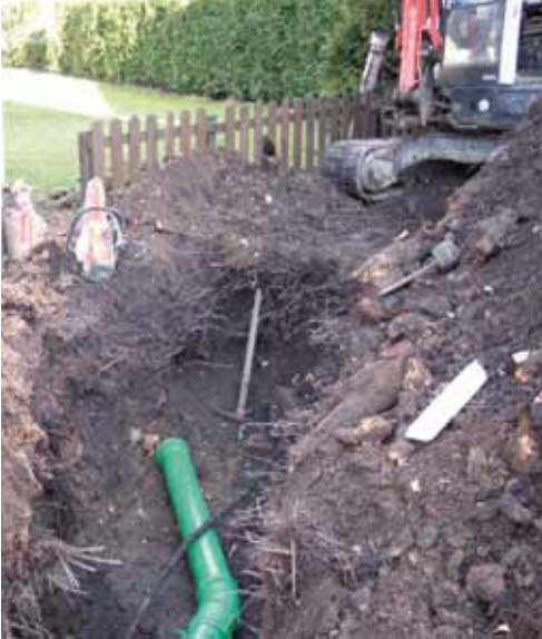
Neuer Kanal für die Abwasserentsorgung der Toilettenanlage zur Rodentelgenstraße.
