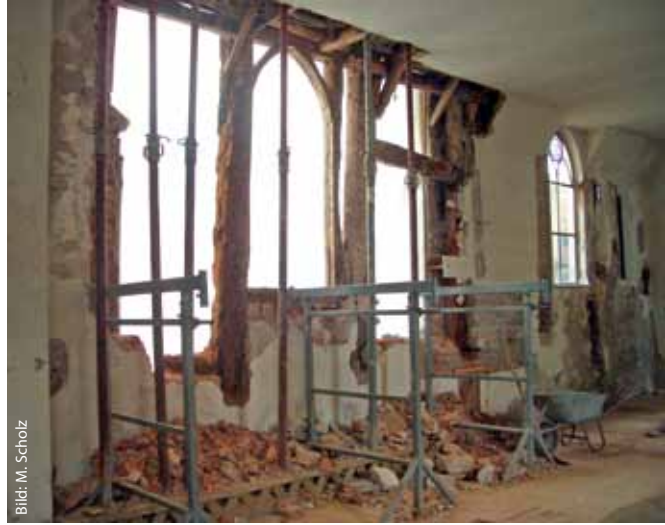
Abgestützte und gesicherte Nordwand.
