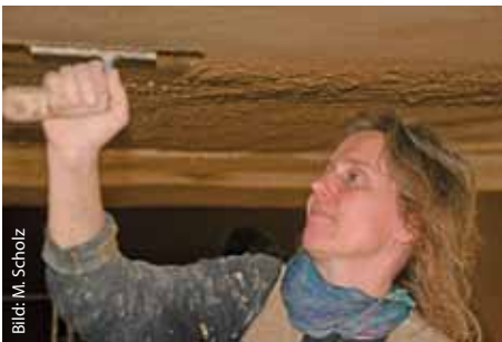
Frau Görler beim Auftragen des Lehmputzes.
