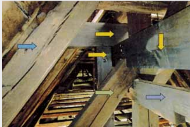
Abb. 2: Detail des neuen „hölzernen Korsetts“ (blauer Pfeil: Dachsparren, grüner Pfeil: alter Strebenbock, lila Pfeil: alte Aussteifung, gelber Pfeil: neue Ergänzungen)
