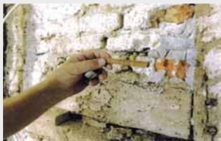
Abb. 3: Dendrochronologische Untersuchung Probenentnahme auf der Südwand.
