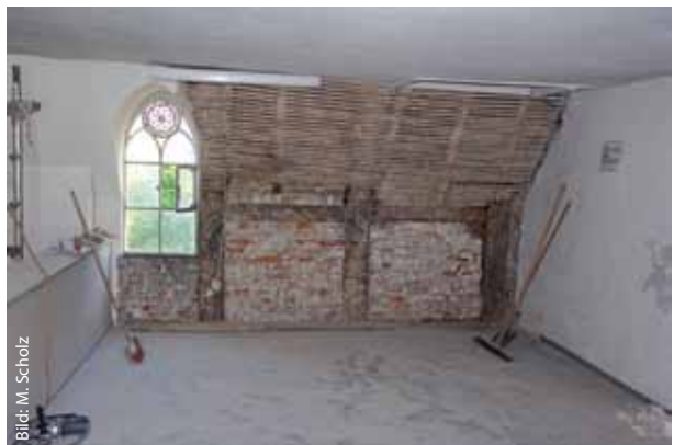
Der freigelegte Drempel auf der Empore nach der Putzentfernung.
