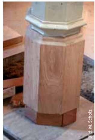
Oben: Die unten abgefaulten Säulen der Empore. Rechts: Fachmännisch angeschuhnte Tragsäule.
