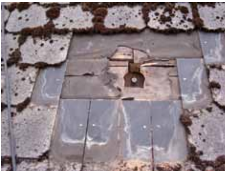
Geöffnete Dachflächen zum Einführen der Zugstangen.
