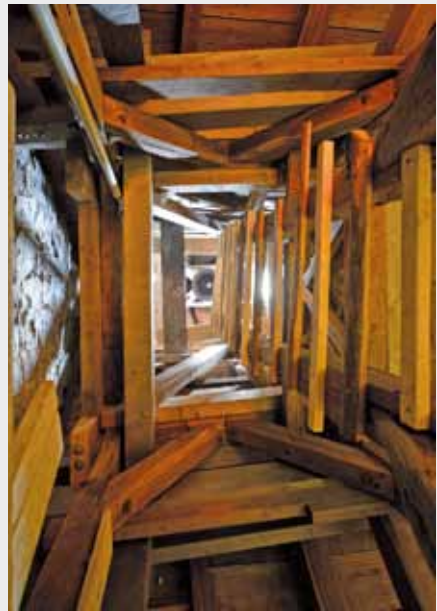
Abb. 4: Blick in den Glockenstuhl (unten die Tritte zum Aufsteigen in den Turm).
