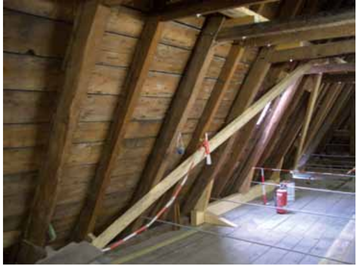
Eingebauter Windverband und Zugstangen stabilisieren das Dach.
