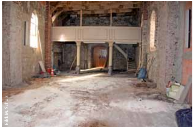
Kapelleninneres nach Entfernung des Putzes und Freilegung des Bodens.
