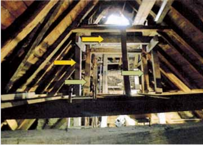
Abb. 5: Blick in historischen Glockenstuhl (grüner Pfeil: alter Strebenbock, gelber Pfeil: neues „hölzerne Korsett“).
