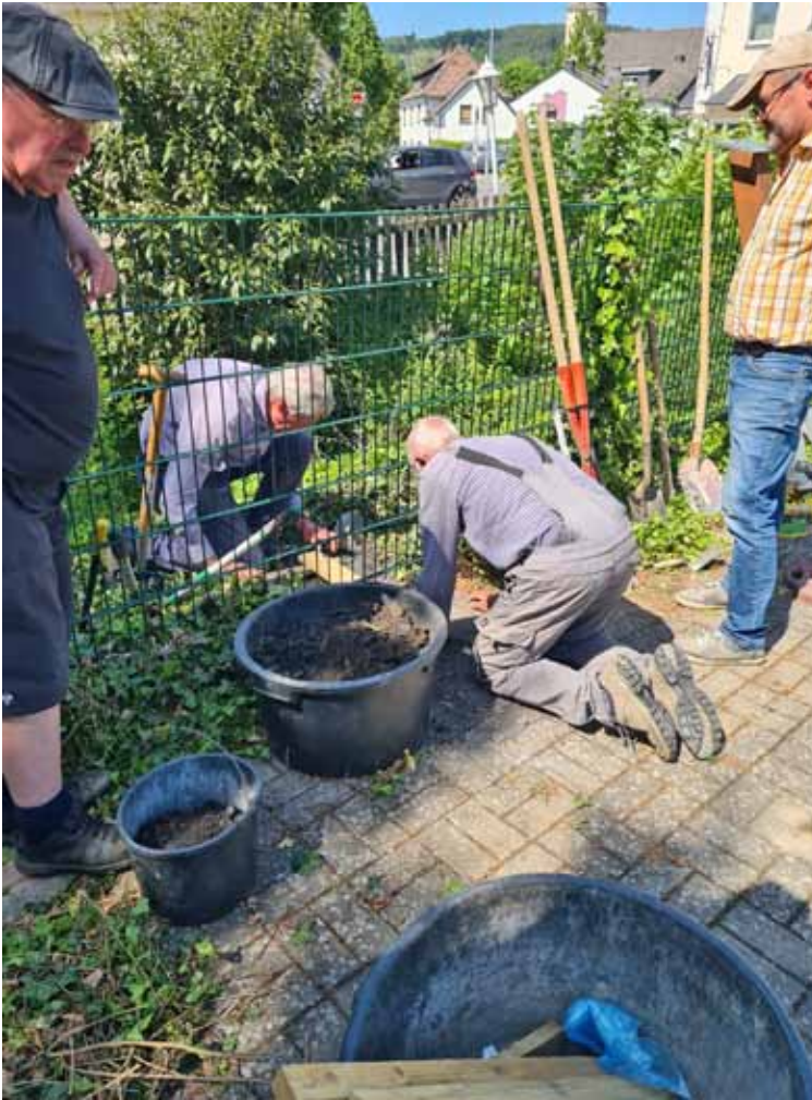
Einige Fundamentlöcher der Stelen mussten in Handschachtung ausgeführt werden.
